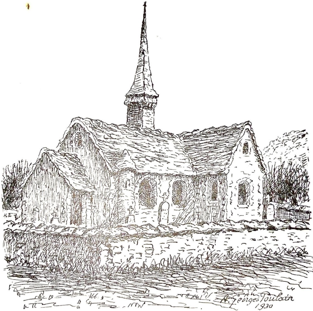
Eglise d'Houlbec (côté sud)
